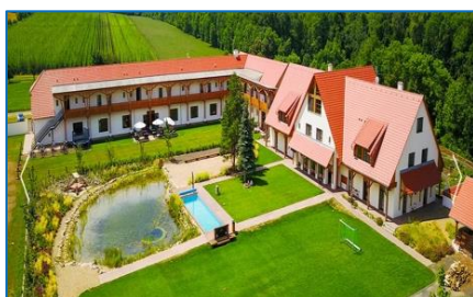
Foto 1 - Gesamtansicht des Gebäudes
