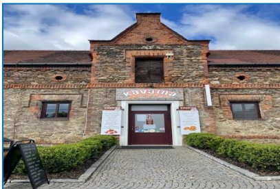
Foto 1 - Gesamtansicht des Gebäudes
