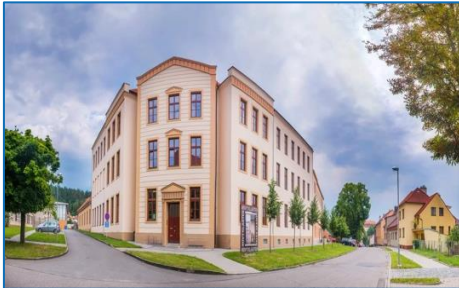
Foto 1 - Gesamtansicht des Gebäudes
